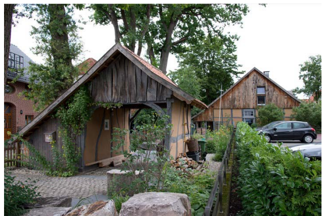
Das Vierständerrhallenhaus mit Remise in Paderborn-Marienloh erhielt eine Anerkennung im Rahmen des Rheinisch-Westfälischen Staatspreises für Denkmalpflege.
